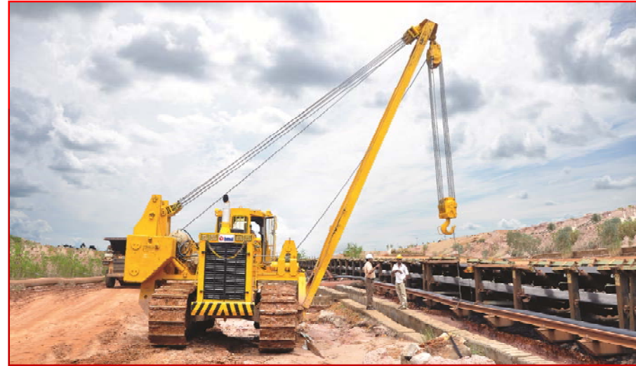
PIPE LAYERS: 41 TON – 100 TON
